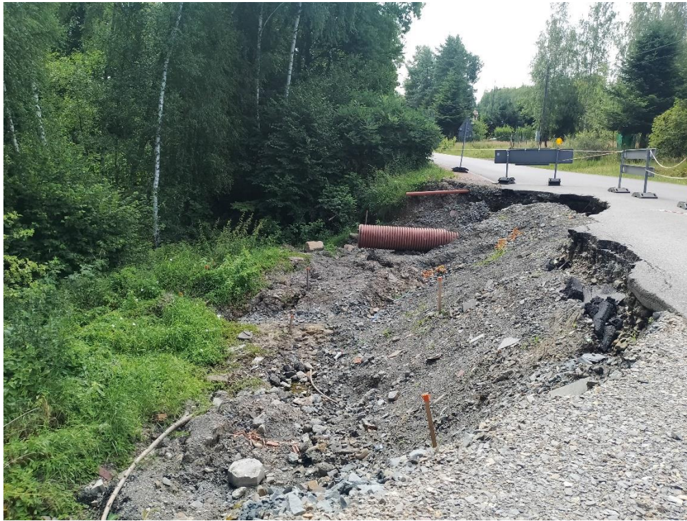
Rys. 2. Widok na skarpę główną osuwiska
