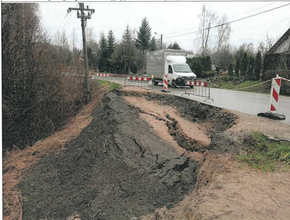
Skarpa główna osuwiska - uszkodzenie korpusu drogi powiatowej
