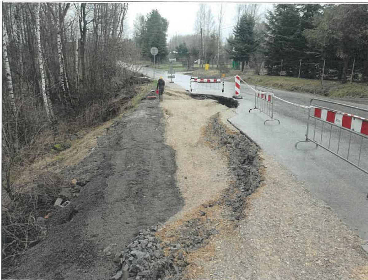
Skarpa główna osuwiska - uszkodzenie jezdni
