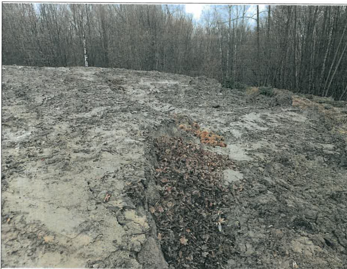
Skarpa główna osuwiska w północnej części (nasyp)
